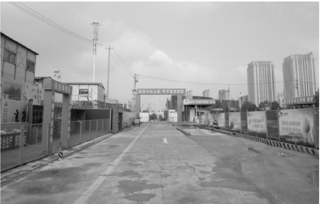
施工道路人车分流
